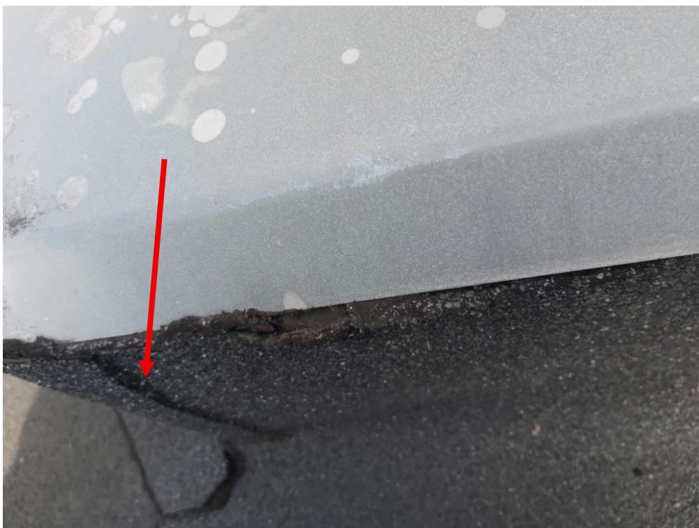
Fot. 30. Odklejona papa na ścianie fundamentu urządzenia
