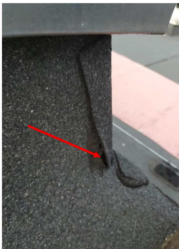
Fot. 27. Odklejona papa na ścianie fundamentu urządzenia
