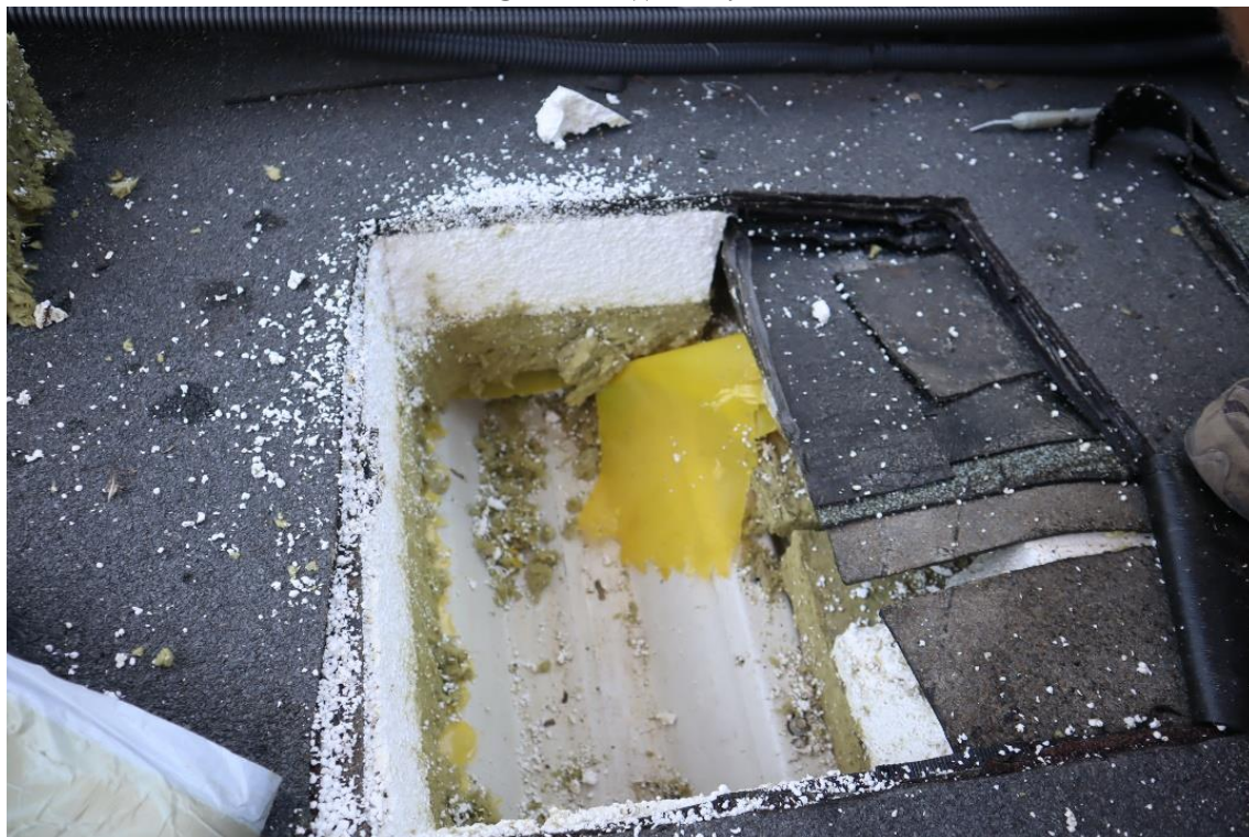
Fot. 60. Odkrywka nr 1 Kilka warstw papy wierzchniego krycia, styropian, wełna mineralna, folia PE, blacha stalowa trapezowa
