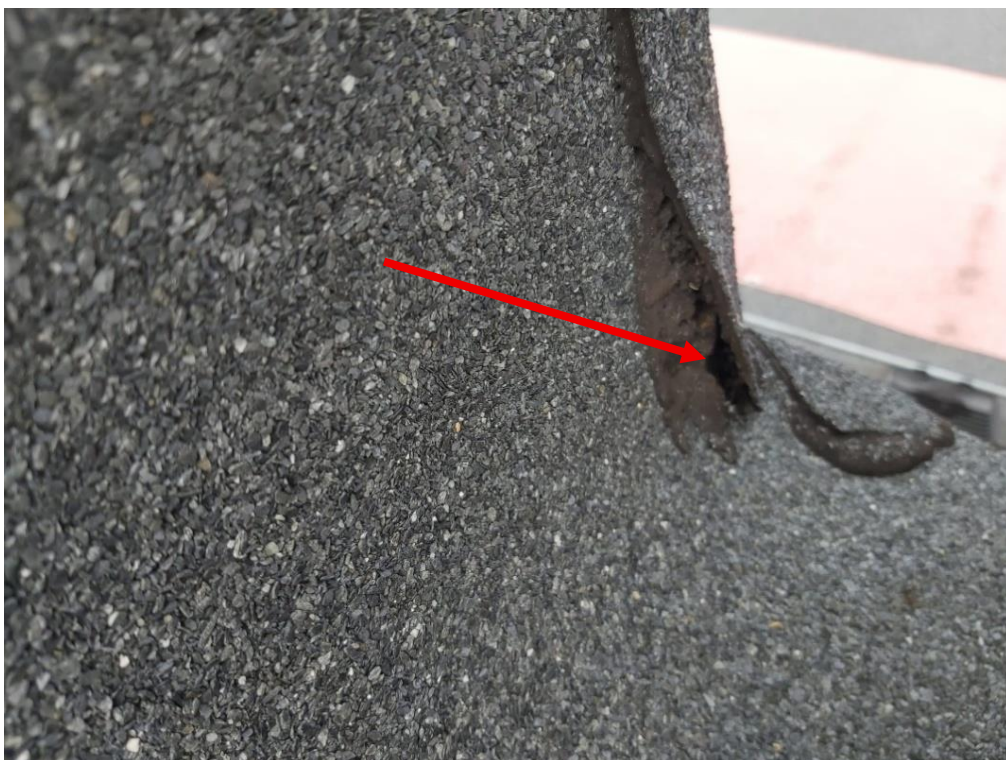
Fot. 28. Odklejona papa na ścianie fundamentu urządzenia
