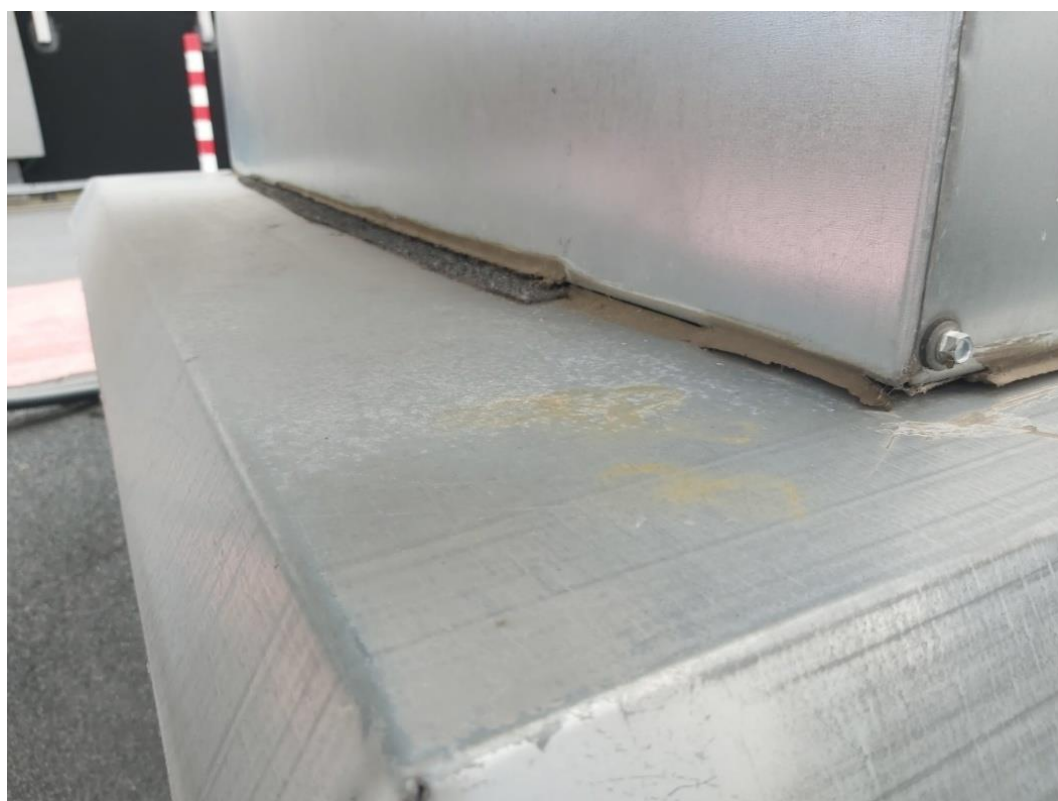
Fot. 57. Nieszczelne połączenia na styku kominka z podstawą
