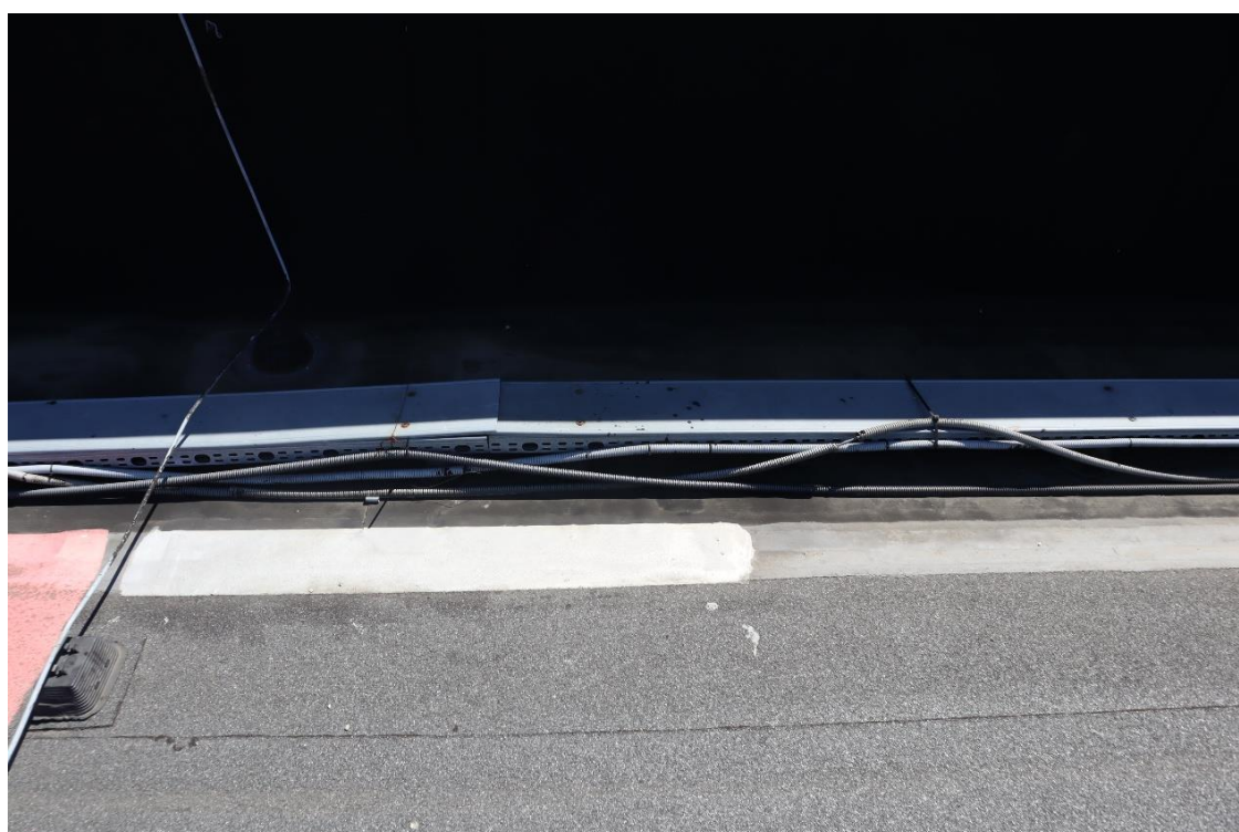
Fot. 45. Do koryt instalacyjnych przymocowano peszle z instalacją
