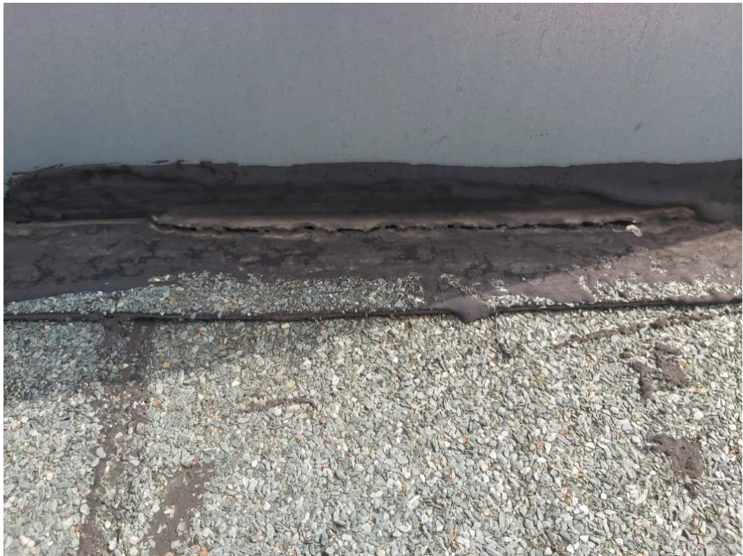
Fot. 52. Nieszczelne połączenia na styku kominka z podstawą
