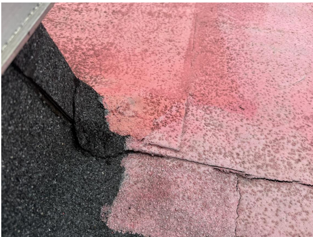
Fot. 22. Pokrycie dachu kilkoma warstwami papy
