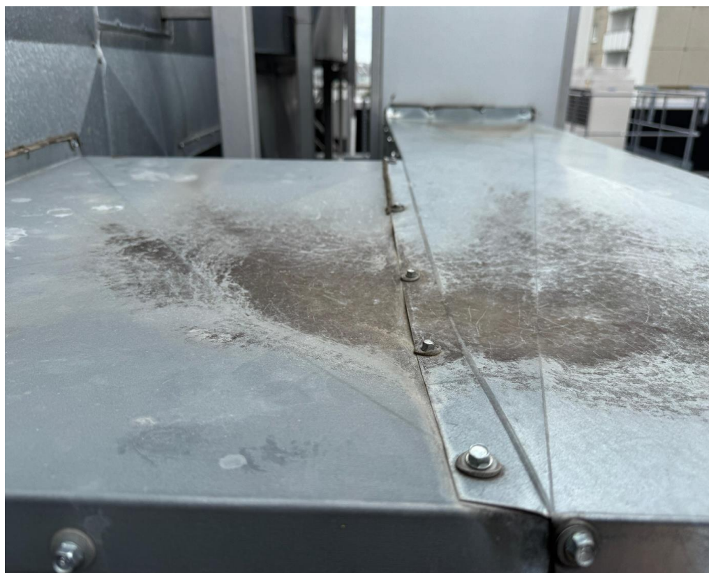
Fot. 47. Nieszczelne połączenie rur wentylacji mechanicznej
