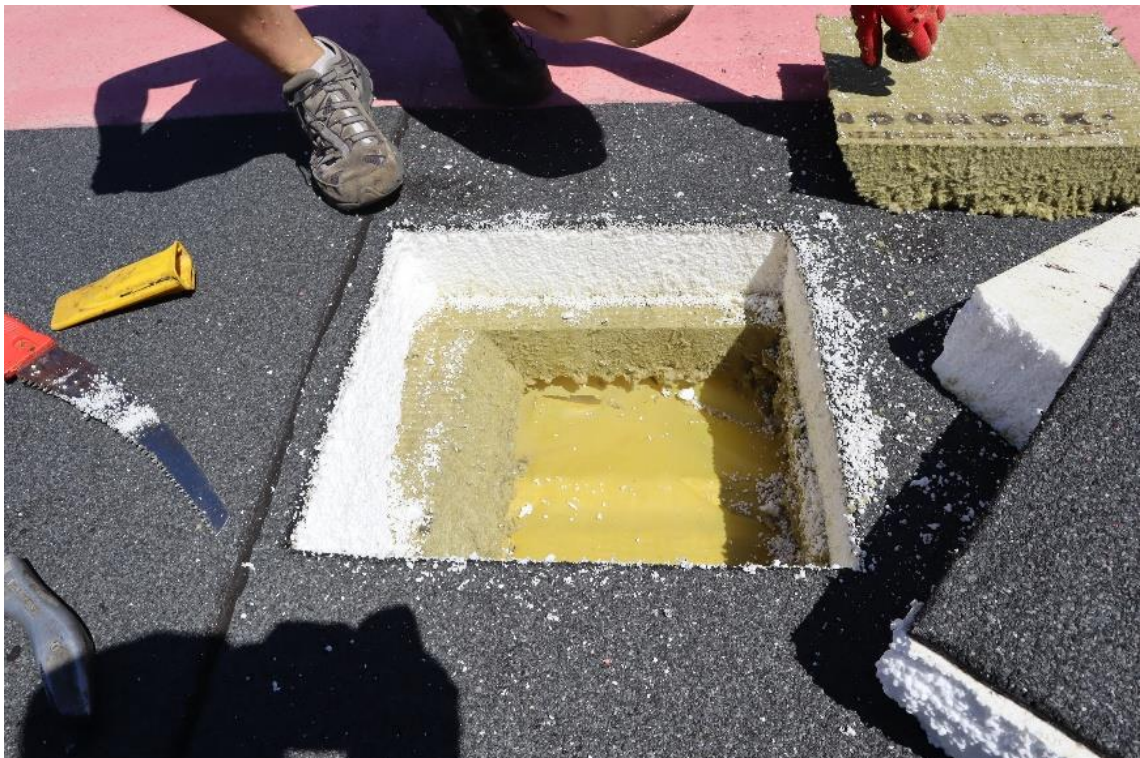
Fot. 65. Odkrywka nr 2 Kilka warstw papy wierzchniego krycia, styropian, wełna mineralna, folia PE, blacha stalowa trapezowa
