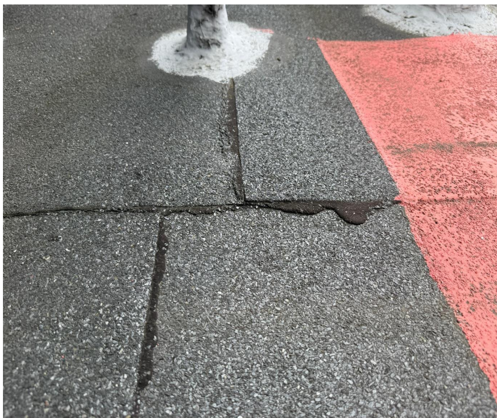
Fot. 23. Wadliwe wytopianie połączenia papy
