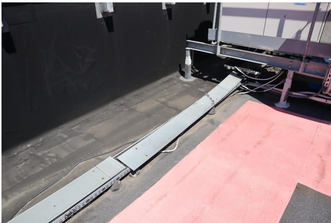
Fot. 44. Do koryt instalacyjnych przymocowano peszle z instalacją
