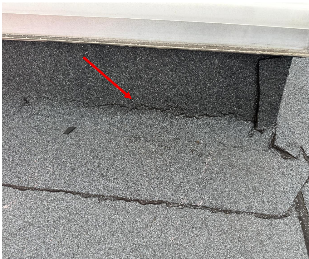
Fot. 14. Pęknięta papa w podstawie wylazu na dach
