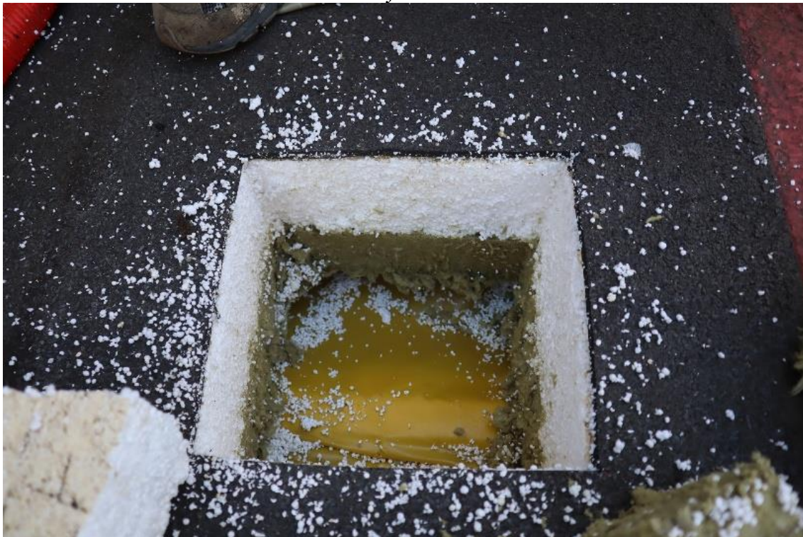
Fot. 72. Odkrywka nr 4 Kilka warstw papy wierzchniego krycia, styropian, wełna mineralna, folia PE, blacha stalowa trapezowa
