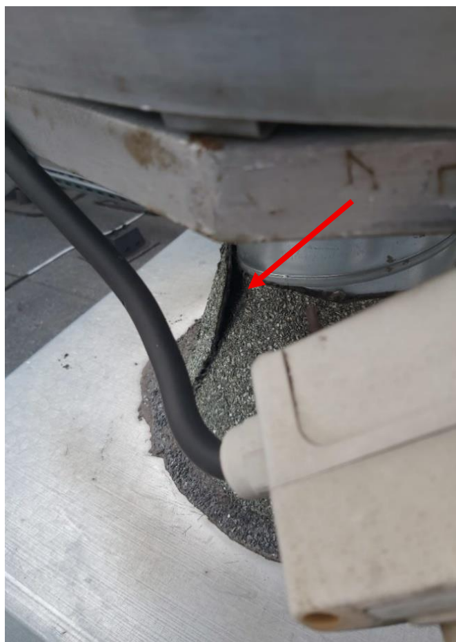
Fot. 14. Nieszczelne połączenie papy na podstawie urządzenia went.
