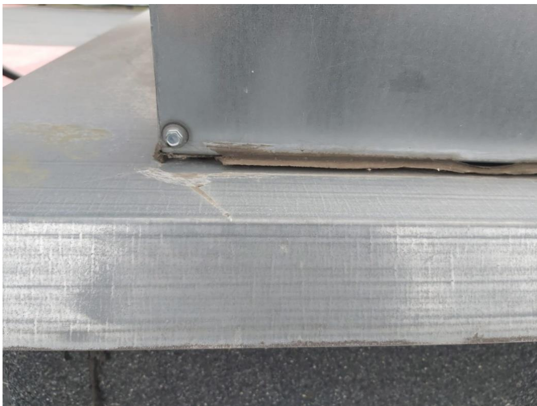
Fot. 56. Nieszczelne połączenia na styku kominka z podstawą
