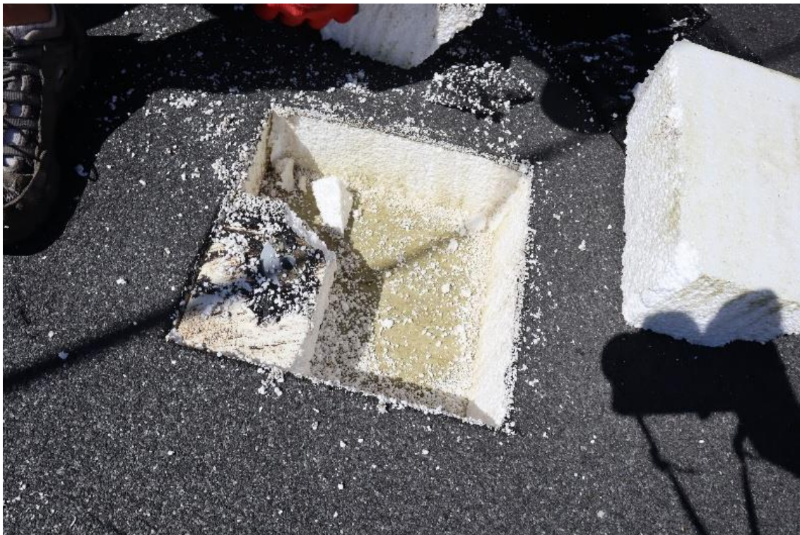
Fot. 68. Odkrywka nr 3 Kilka warstw papy wierzchniego krycia, styropian, wełna mineralna, folia PE, blacha stalowa trapezowa
