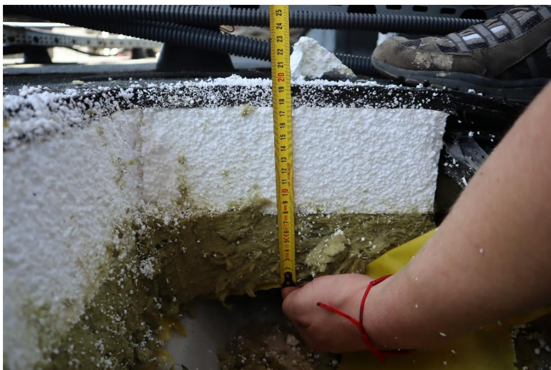
Fot. 61. Odkrywka nr 1 Warstwy papy wierzchniego krycia, styropian, wełna mineralna, folia PE
