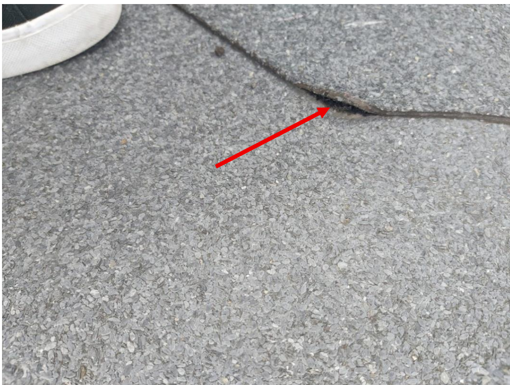
Fot. 32. Odklejona papa na ścianie fundamentu urządzenia
