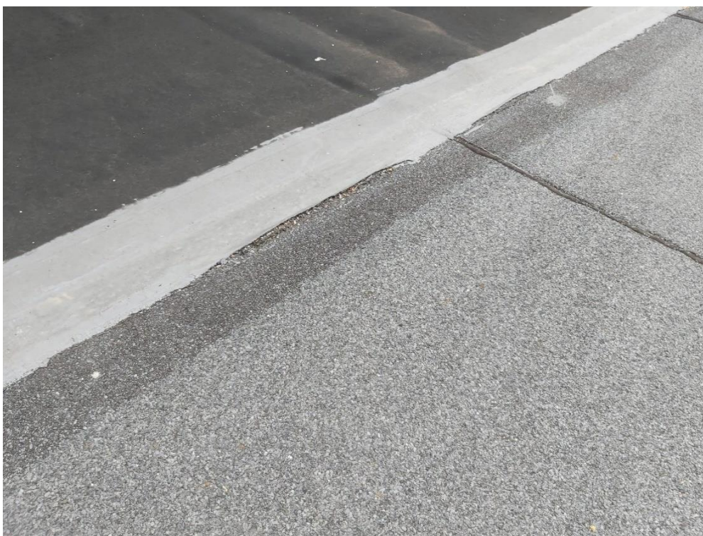
Fot. 15. Łączenie pasa membrany z papą za pomocą płynnej membrany
