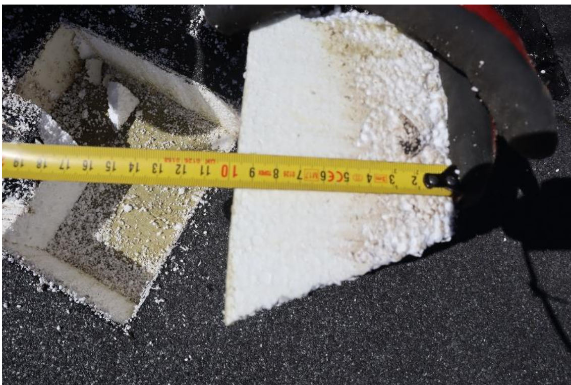
Fot. 69. Odkrywka nr 3 Styropian gr. 10 cm
