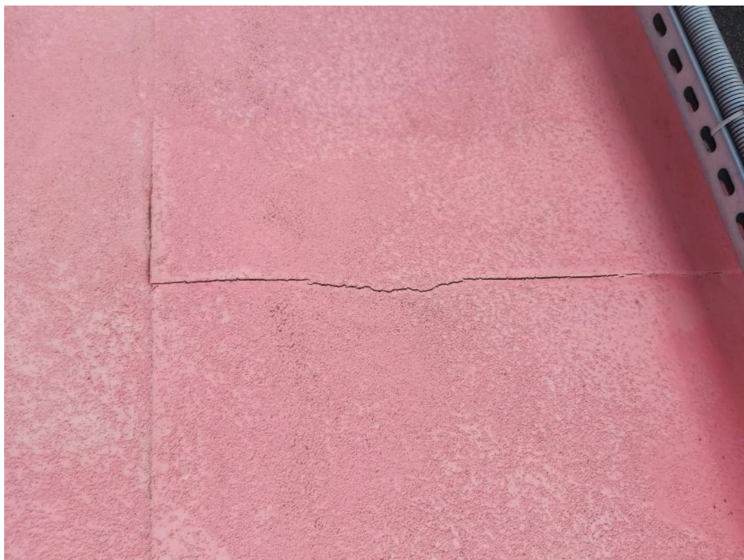
Fot. 20. Pęknięcia papy na łączeniu
