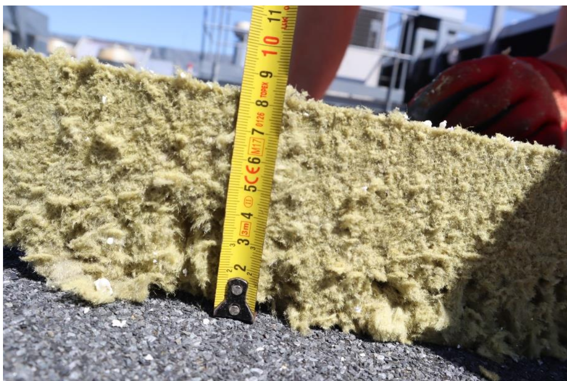
Fot. 67. Odkrywka nr 2 Wełna mineralna gr. 8 cm
