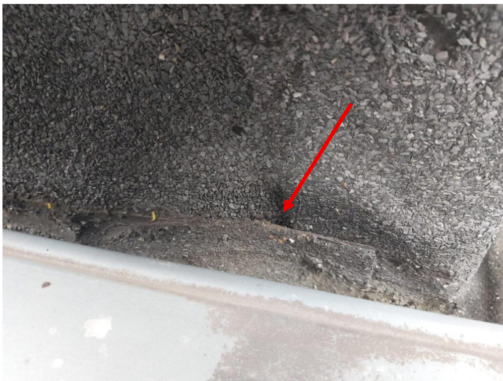
Fot. 13. Punktowe nieszczelności papy na styku podłoża z obudową fundamentu urządzenia
