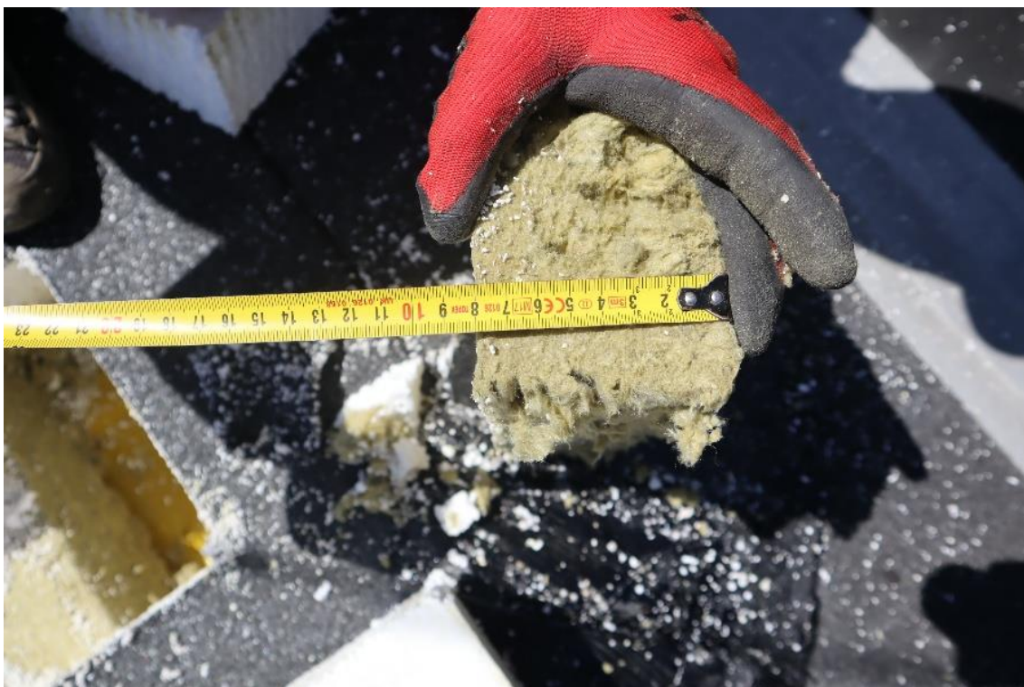
Fot. 70. Odkrywka nr 3 Wetna mineralna gr. 8 cm
