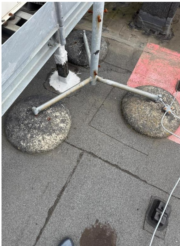
Fot. 38. Podstawy betonowe masztu bez podkładek
