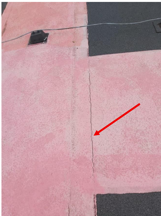
Fot. 18. Pęknięcia papy na łączeniu poszczególnych warstw
