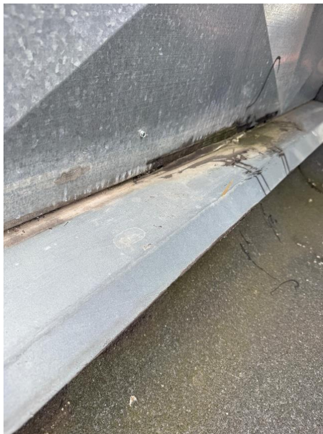
Fot. 51. Nieszczelne połączenia na styku kominka z podstawą
