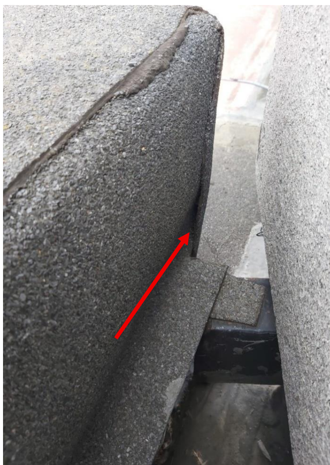
Fot. 33. Odklejona papa na ścianie fundamentu urządzenia
