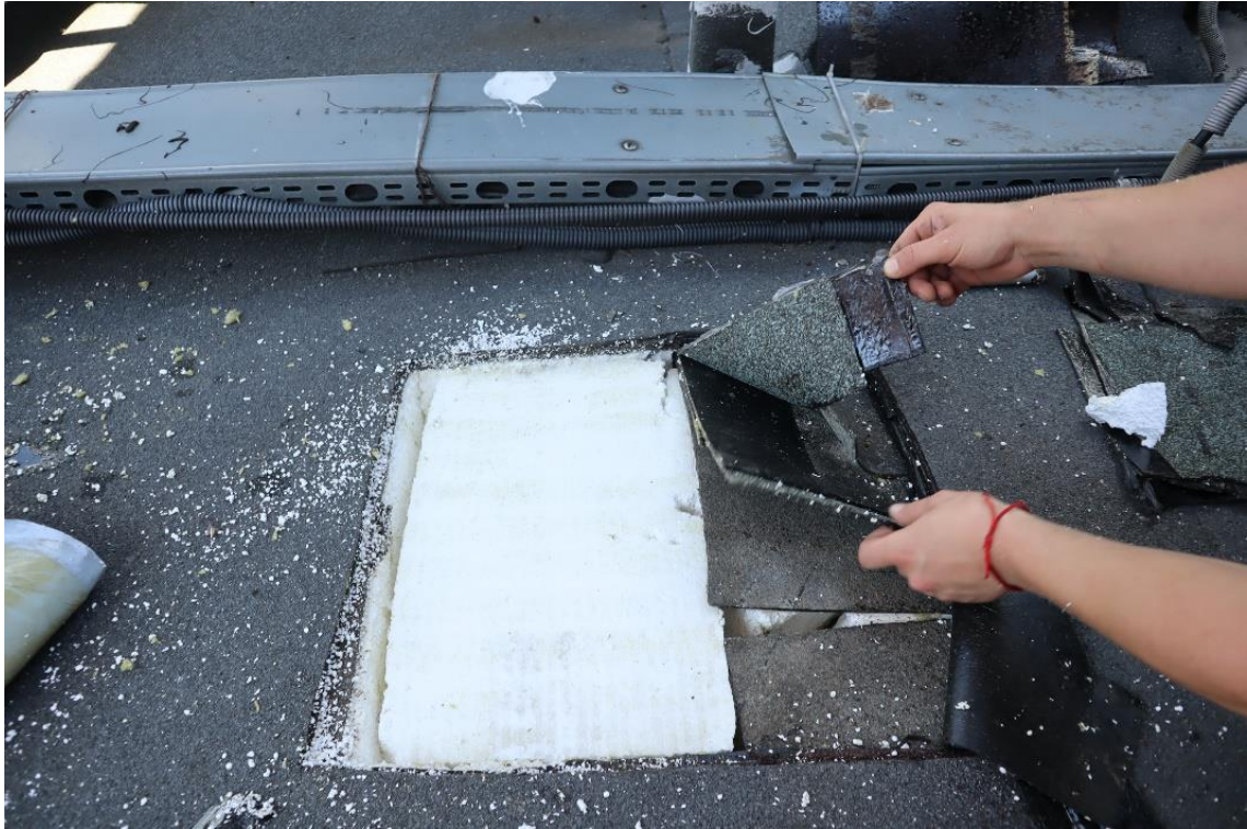
Fot. 64. Odkrywka nr 2 Kilka warstw papy wierzchniego krycia, styropian, wełna mineralna, folia PE, blacha stalowa trapezowa
