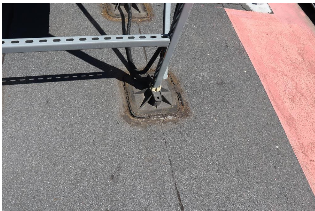
Fot. 39. Stopy urządzeń wtopione w papę
