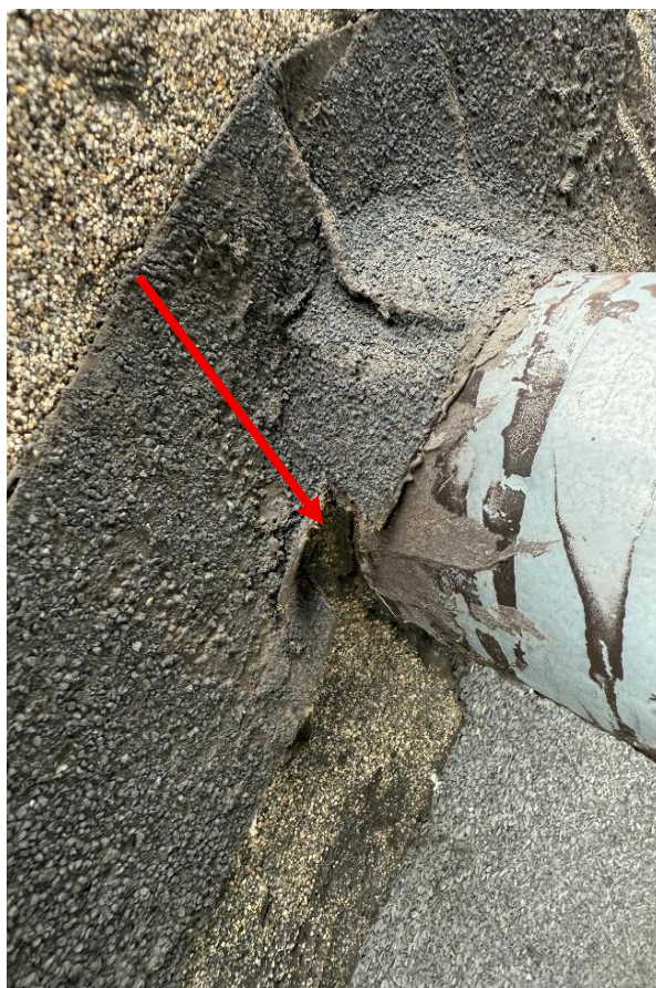
Fot. 37. Wadliwie wykonana izolacja przejścia rury przez ścianę
