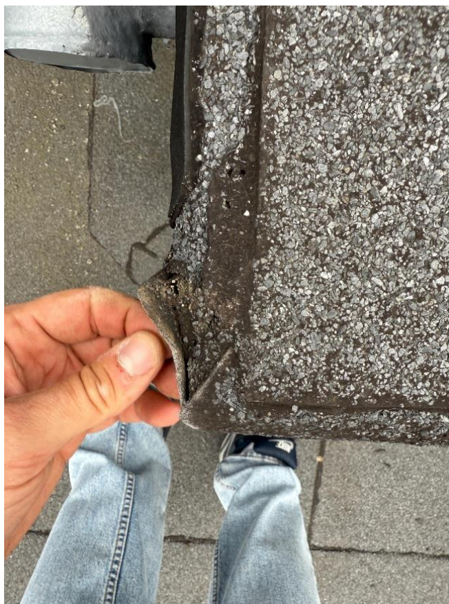
Fot. 24. Odklejona papa na krawędzi obudowy
