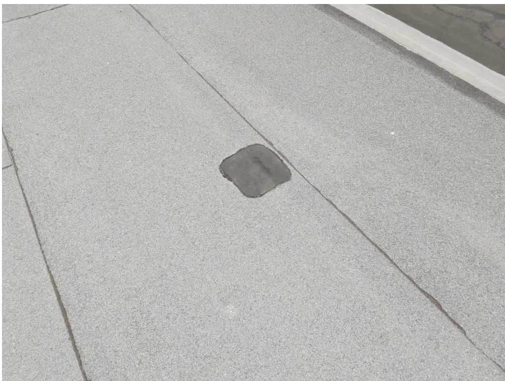
Fot. 11. Miejscowe naprawy papy za pomocą membrany
