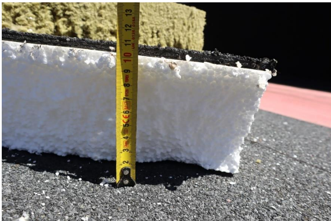
Fot. 66. Odkrywka nr 2 Styropian gr. 10 cm
