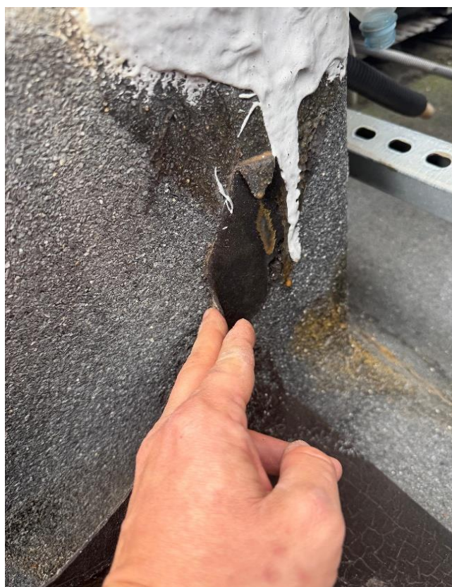
Fot. 17. Odklejona papa w narożniku podstawy urządzenia
