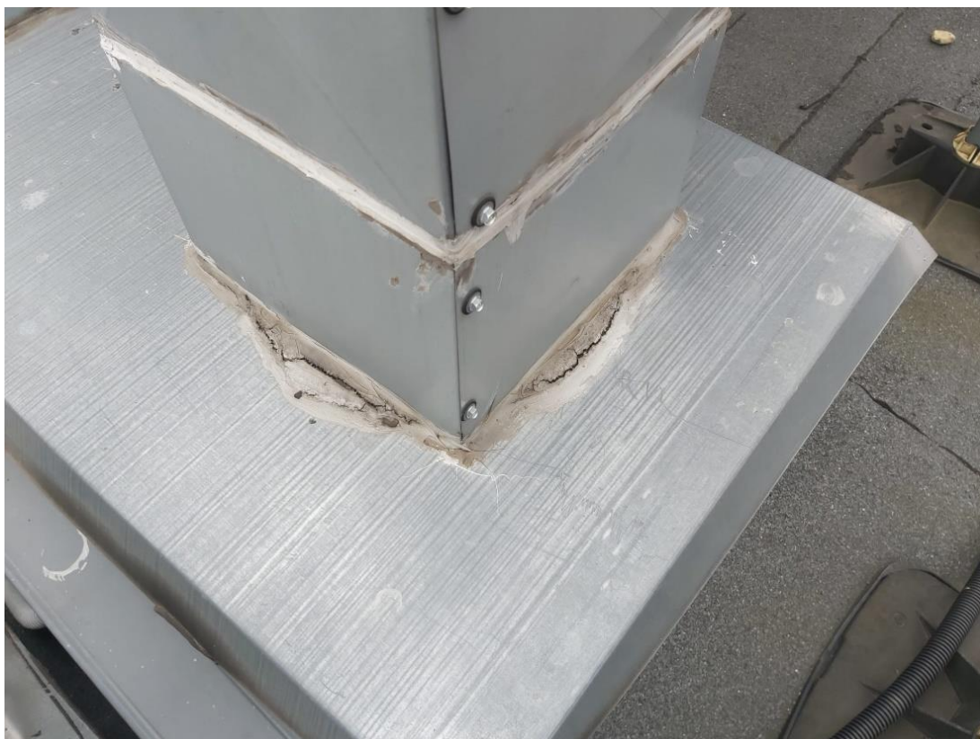
Fot. 48. Nieszczelne połączenia na styku kominka z podstawą
