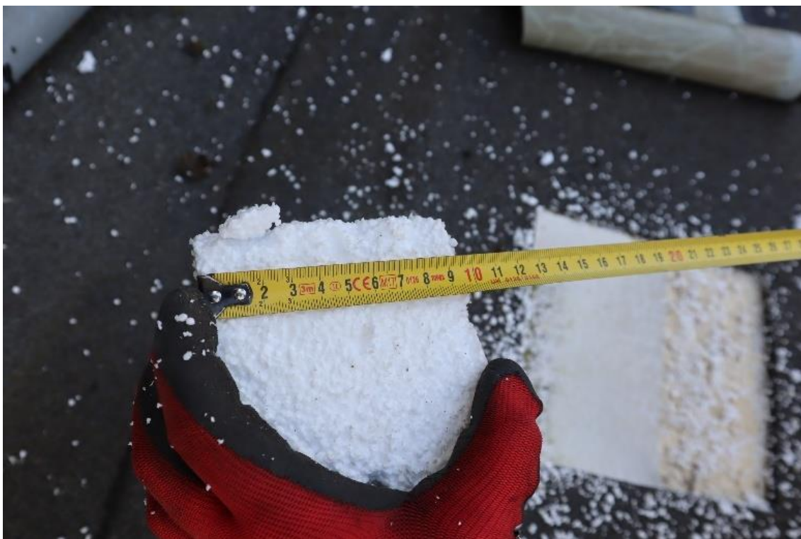
Fot. 73. Odkrywka nr 4 Styropian gr. 10 cm
