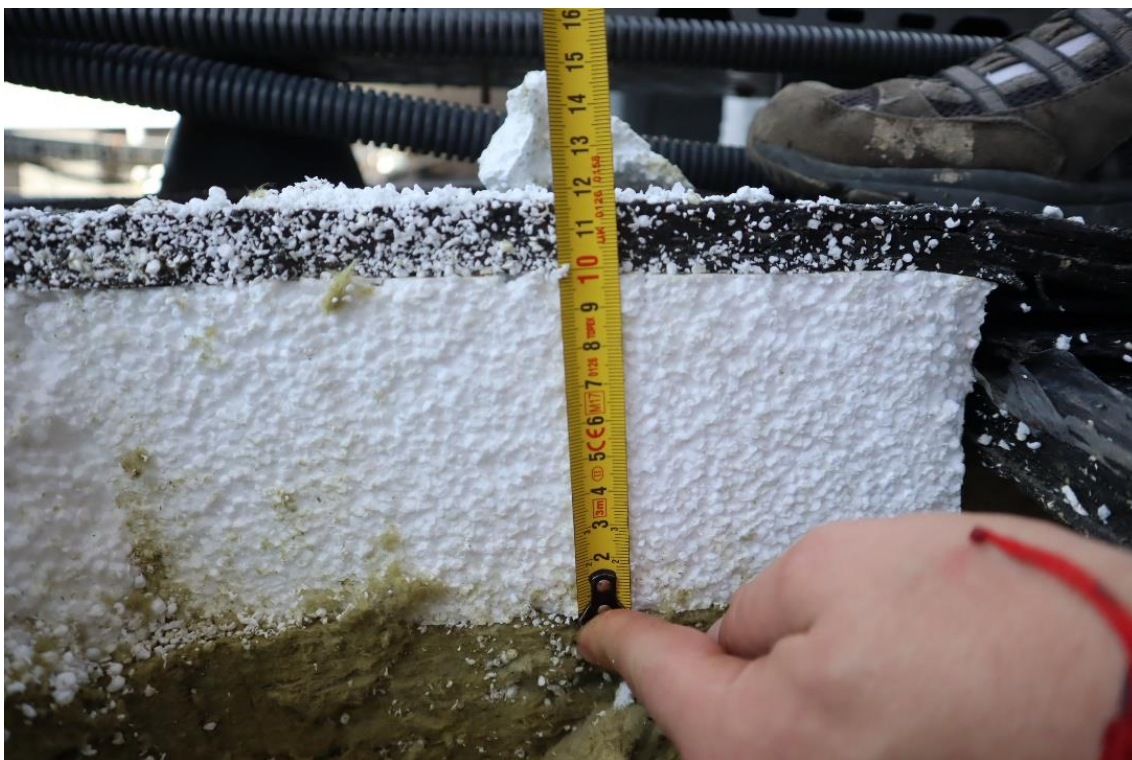
Fot. 62. Odkrywka nr 1 Warstwy papy wierzchniego krycia gr. 20 mm, styropian gr. 10 cm
