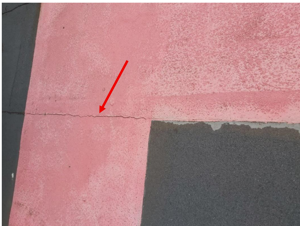
Fot. 19. Rozszerzona papa na stykach
