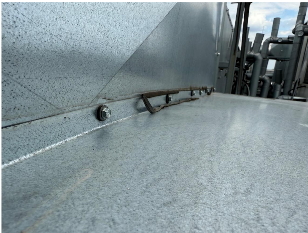
Fot. 54. Nieszczelne połączenia na styku kominka z podstawą
