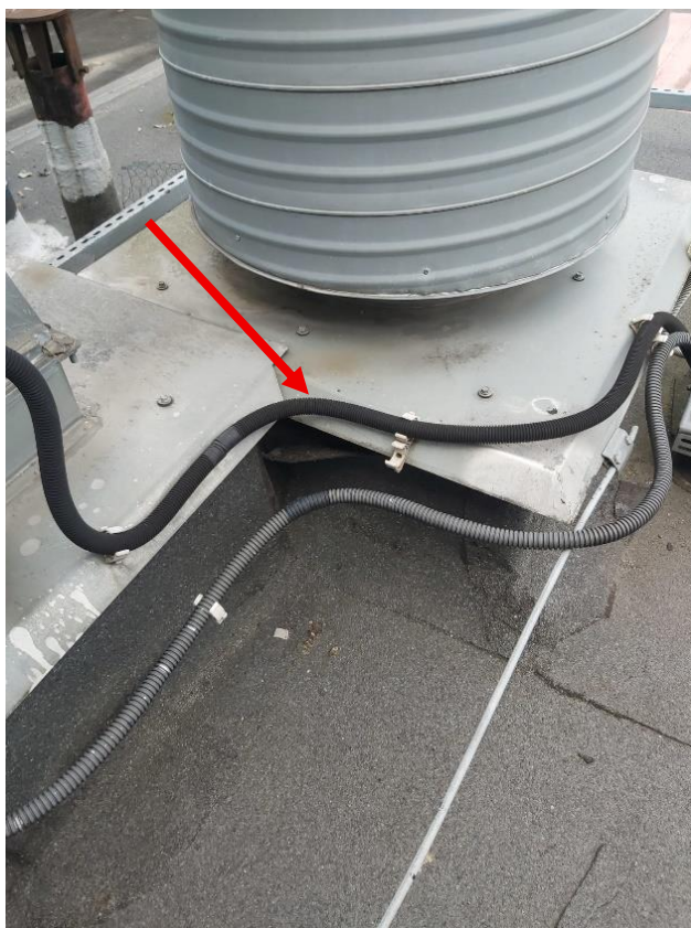
Fot. 26. Odklejona papa na ścianie fundamentu urządzenia
