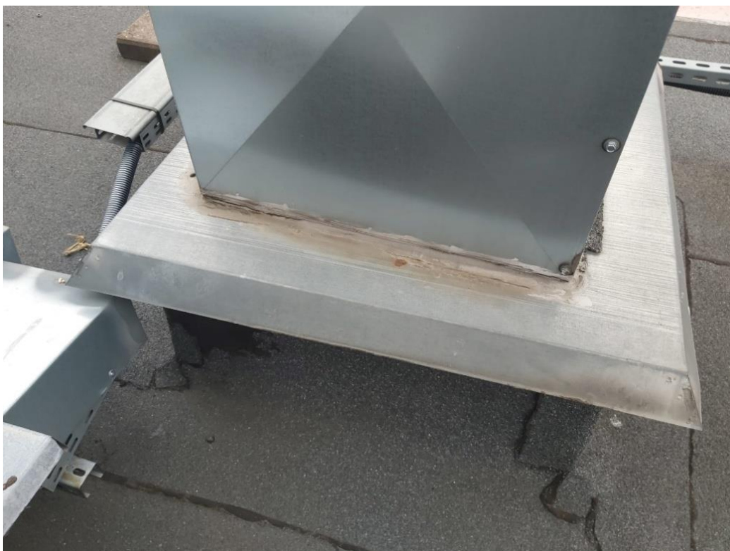
Fot. 55. Nieszczelne połączenia na styku kominka z podstawą
