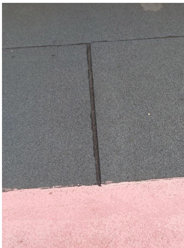
Fot. 21. Przesunięta papa na łączeniu
