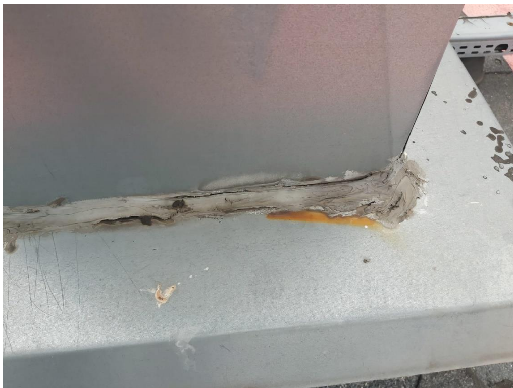
Fot. 46. Nieszczelne połączenia na styku kominka z podstawą
