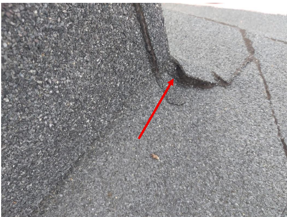
Fot. 29. Odklejona papa na ścianie fundamentu urządzenia
