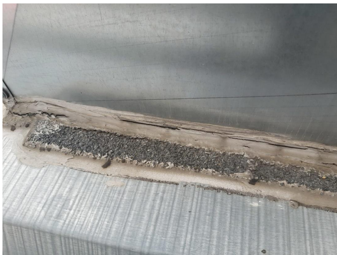
Fot. 49. Nieszczelne połączenia na styku kominka z podstawą
