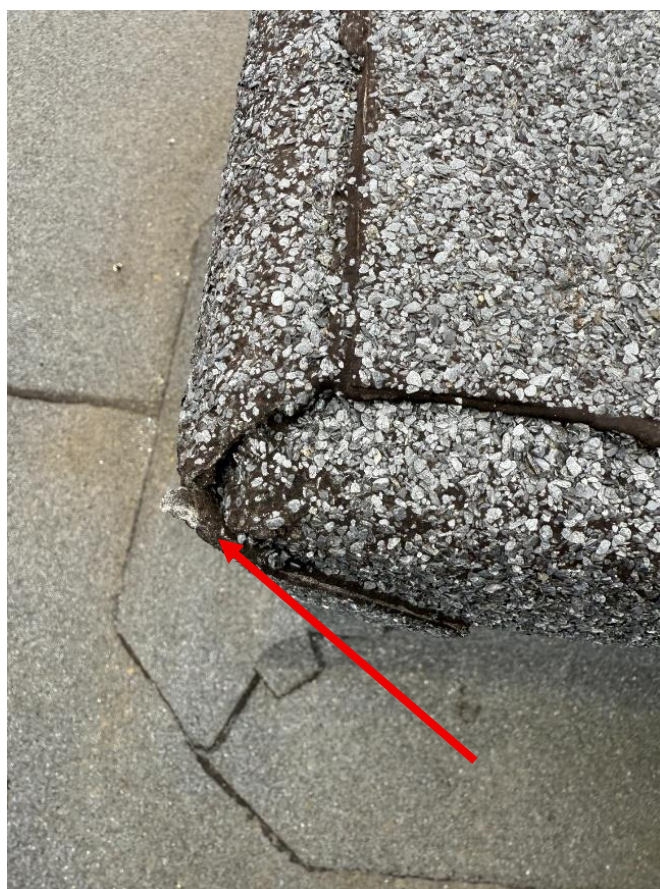
Fot. 31. Odklejona papa na ścianie fundamentu urządzenia
