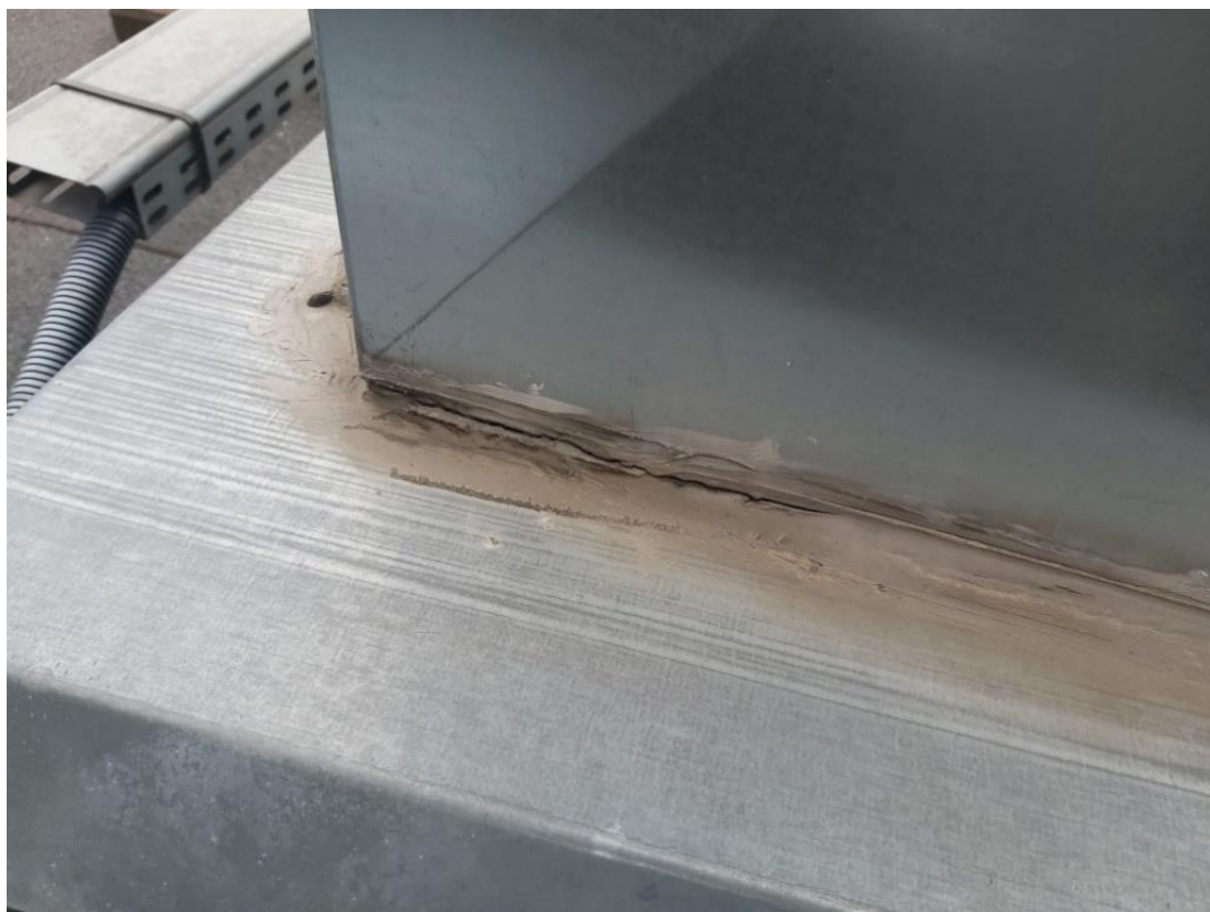
Fot. 50. Nieszczelne połączenia na styku kominka z podstawą
