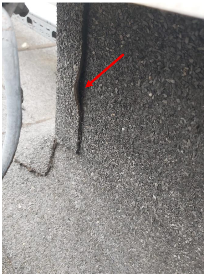
Fot. 16. Odklejona papa w narożniku podstawy urządzenia
